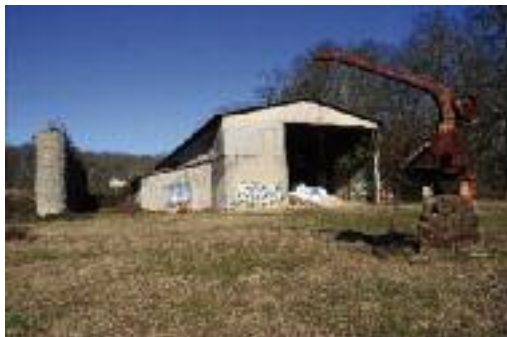
Area mineraria in località Solfatara
